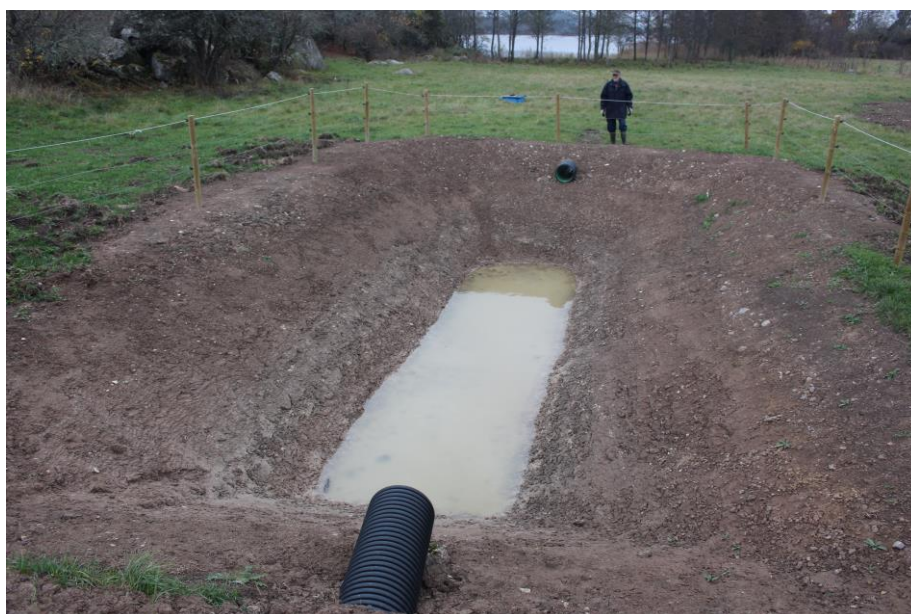
Figur 10. Mindre fälla på Väsby. Trots låg tillrinning så var det vatten som stod i fällan lergrumligt. Vid utloppet ses Nimmerns Grand old man, Jan Gustafsson. Foto: Carl-Johan Månsson
