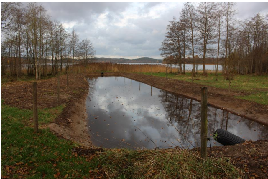
Figur 13. Fälla på Stjärnevik. Mörkt brunt vatten och viss grumlighet. Foto: Carl-Johan Månsson
