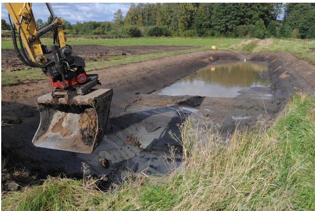
Fosfordamm grävs. Notera de mäktiga lerlagren som grävts fram. Foto: Jan Gustafsson
