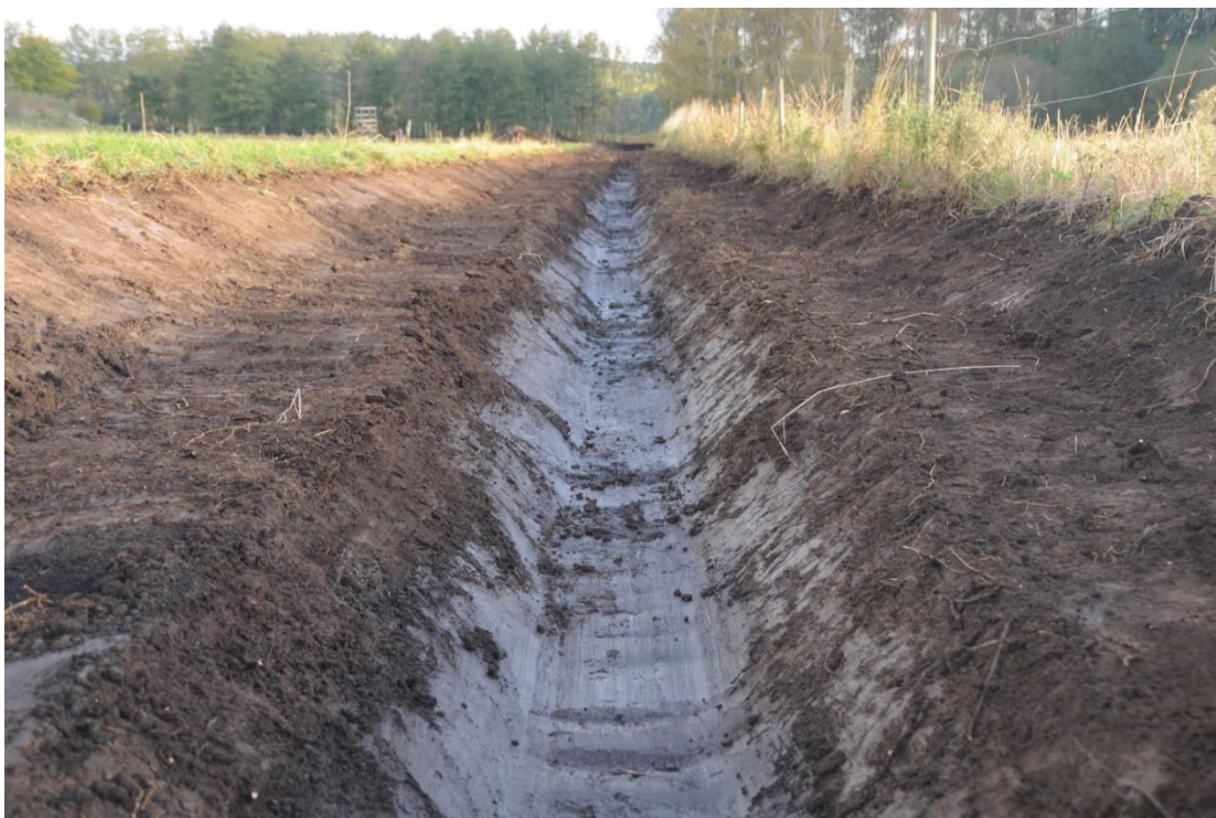
Tvåstegsdike på Väsby. Tanken är att vattnet ska kunna gå upp på sidorna så blir näringsupptaget större. Mätningar har indikerat att funktionen fungerar. Foto Jan Gustafsson
