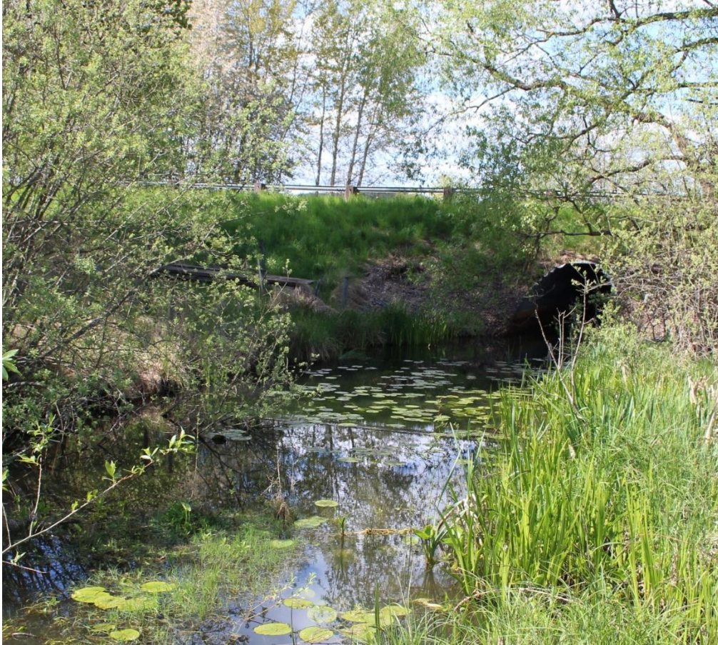
Foto på vägtrumman och ån mellan Nimmern och Åsunden, 2016-05-17.
